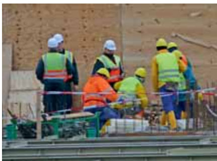
Auf Baustellen im Einsatz: Zu den Aufgaben des Zolls gehört auch die Bekämpfung von Schwarzarbeit. Foto: Zoll
